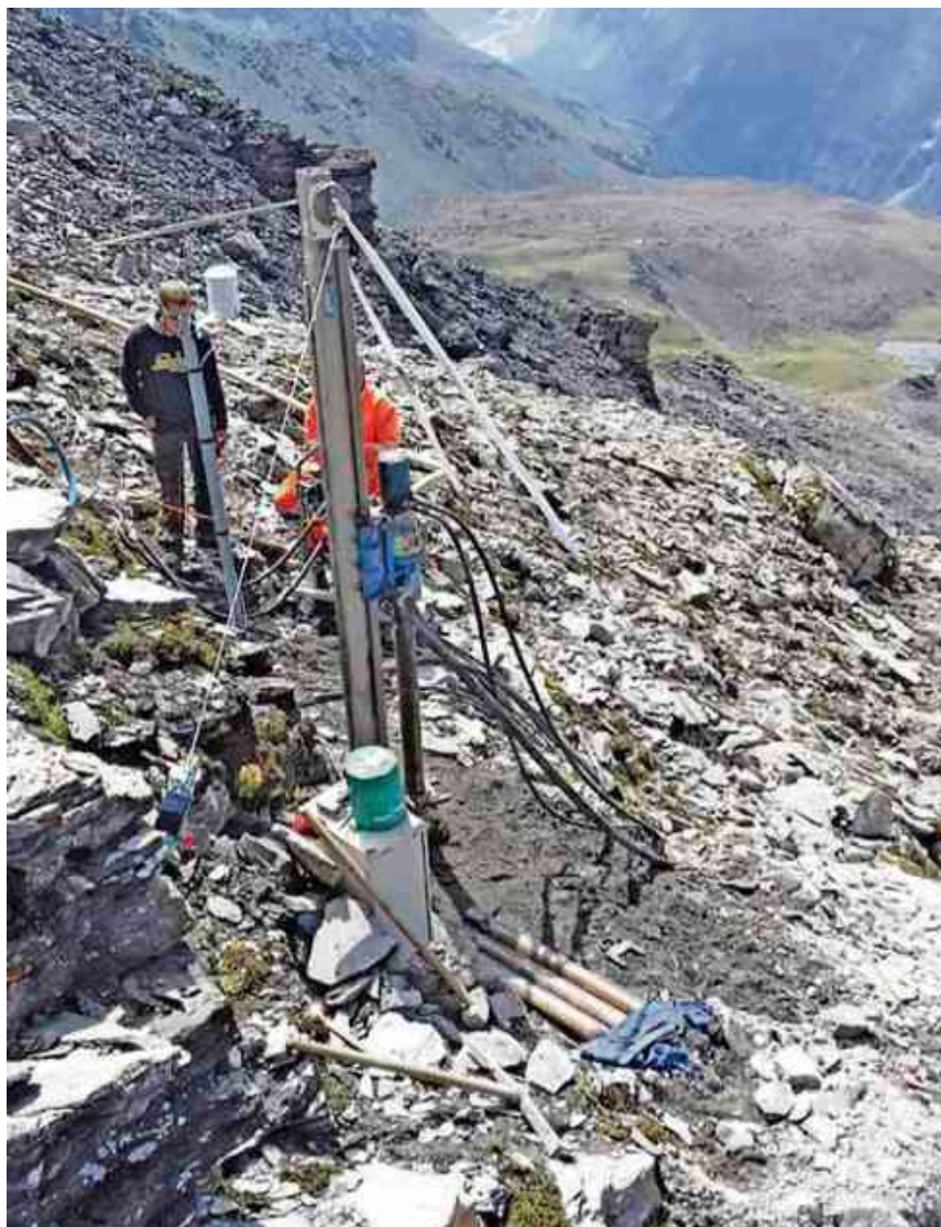
Lavori di perforazione per nuovi pozzi nei siti PERMOS. (Tratte dall'ultimo rapporto; Permos; Foto: C. Lambiel)
